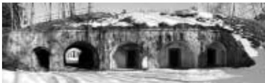
Atelier d'assemblage de munitions Ouest
