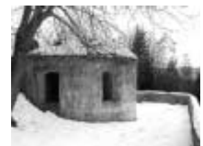
Après la crise l'obus torpille, le poste de télégraphie optique du fort est remplacé par un modèle en béton spécial.
